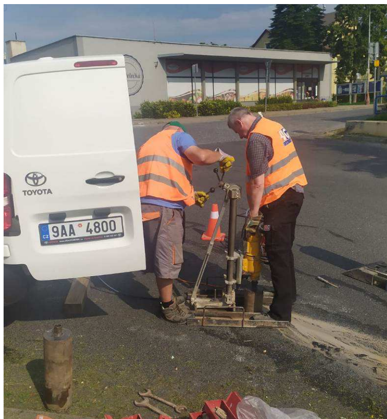
Sonda S1 – jádrový vývrt DIA vrtačkou
